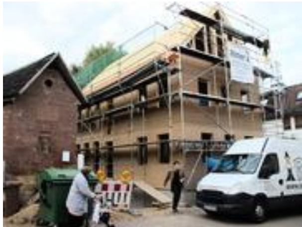
In der Kaicher Obergasse entstehen neue, moderne Wohnungen. (Fotos: jwn)
