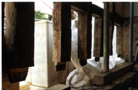
Entfernter Grund- bzw. Ringbalken Foto: Horst Alsleben
