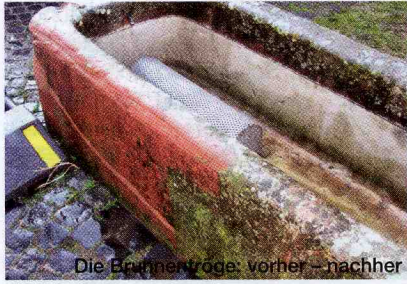
Die Brunnenwanne: vorher - nachher
