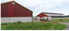
In der Nähe der Maschinenhalle und des Bullenstalls will der Investor an der Erbstädter Höhe seine Biogasanlage errichten. (Foto: udo)
