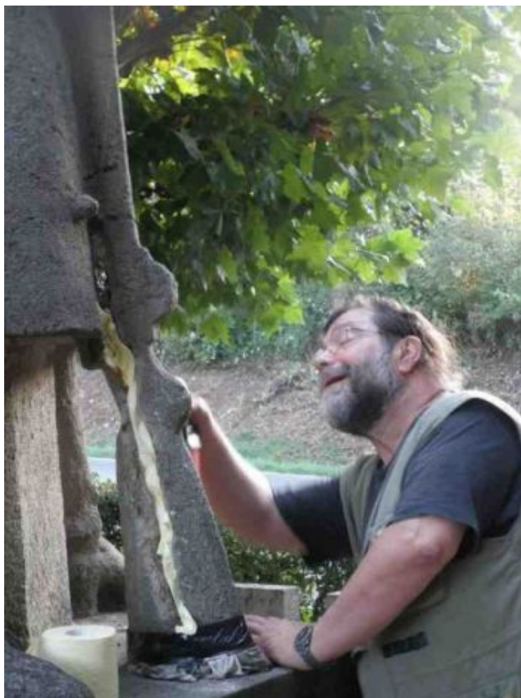
Hans Lang bei der Sanierung des Denkmals
