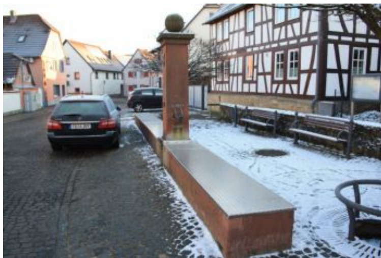
Die neue Weedabdeckung aus geriffeltem Aluminiumblech
