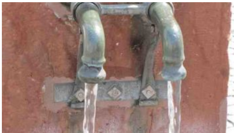
Nach über 50 Jahren fließt wieder Wasser aus den Originalhähnen
