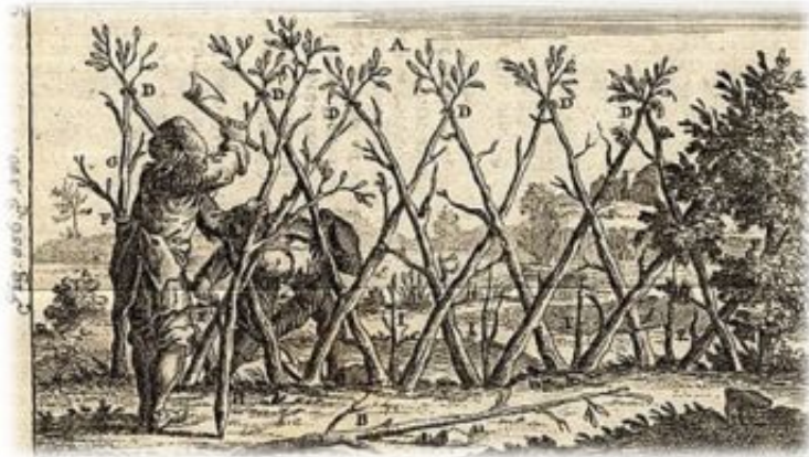
Darstellung zur Anlage einer Hainbuchenhecke als Wall, Bild: Wikipedia
