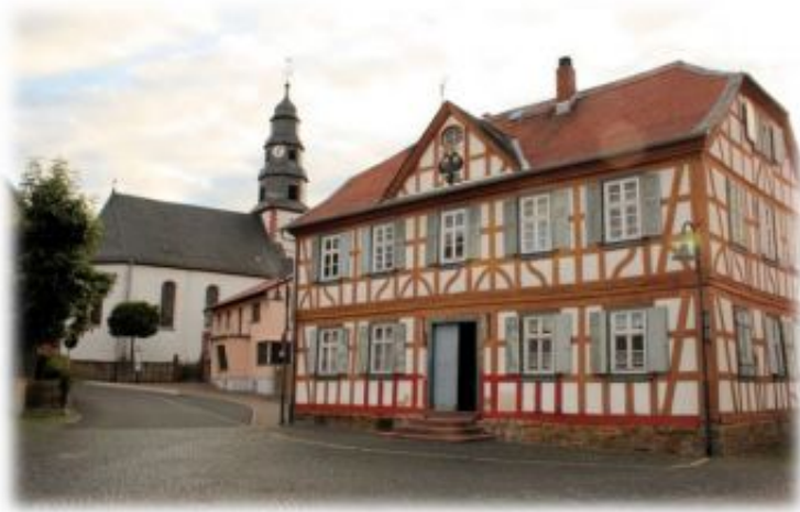
Altes Amtshaus der Burg Friedberg vor Sanierung 2022, Foto: H.Fink
